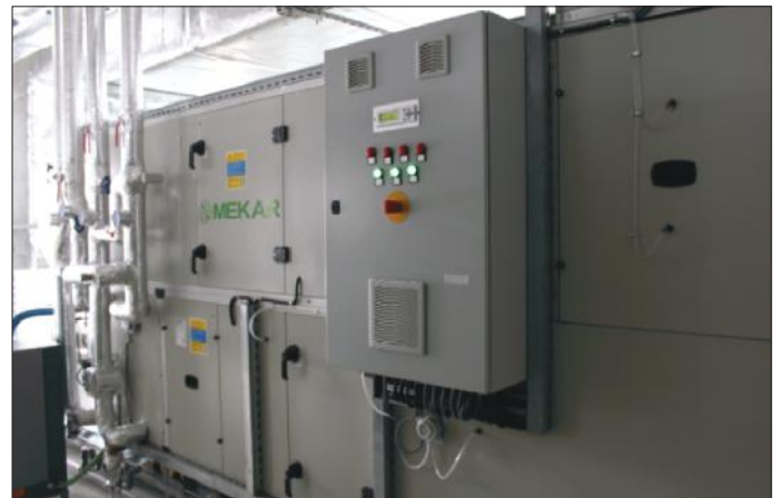
Fig. 3 Centrala de tratare a aerului pentru recepție și foaier
