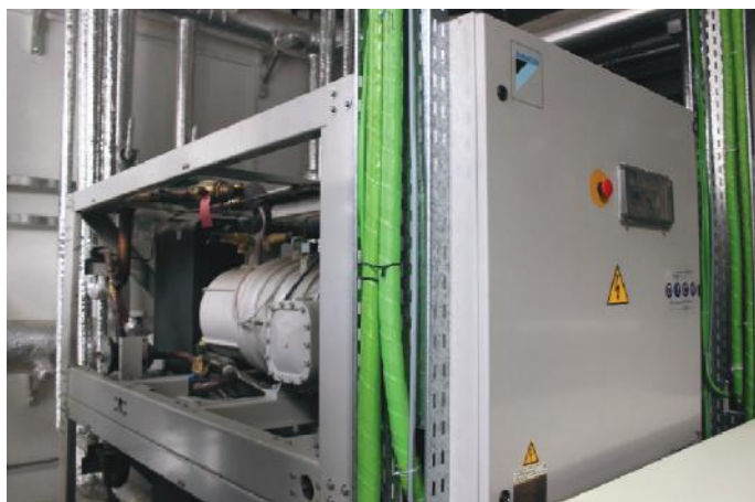
Fig. 8 Agregatele de apă răcită
