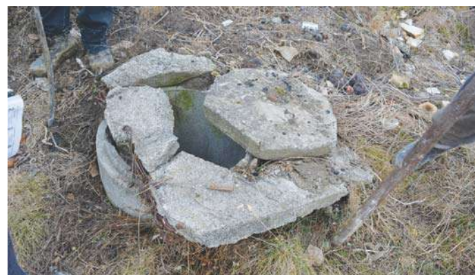
Fig. 4. Rama din beton ruptă
