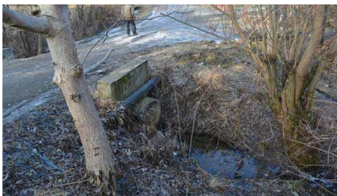
Fig. 2. Trecerea conductei de canalizare peste pârau
