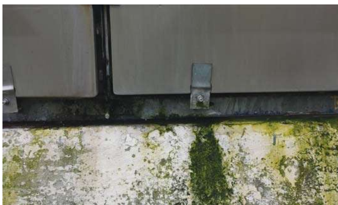
Fig. 8. Rezervoare neetanșe
