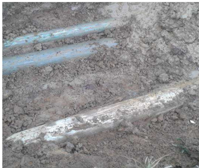
Fig. 6. Conducte montate sub adâncimea de îngheț
