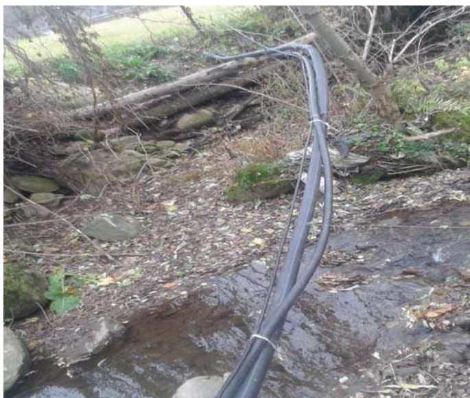
Fig. 5. Trecerea conductei de alimentare cu apă, peste un pârâu
