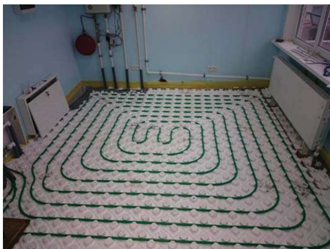
a) Vederea montajului tuburilor circuitului trei
