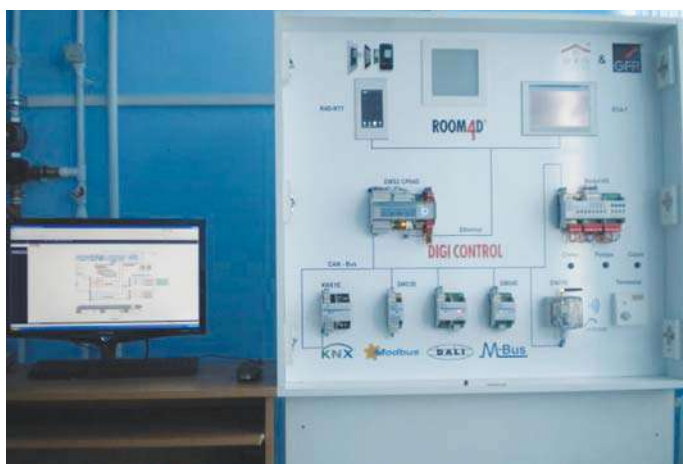
Fig. 3 Vederea panoului de automatizări a complexului de instalații din dotarea încăperii experimentale
