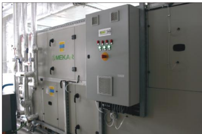
Fig. 3 Centrala de tratare a aerului pentru recepție și foaier
