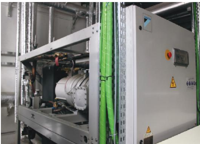
Fig. 9 Agregatele de apă răcită
