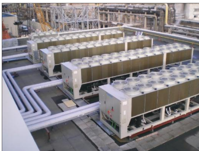
Fig.5 Agregatele de apă răcită
